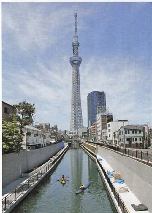
名所となった十間橋より
