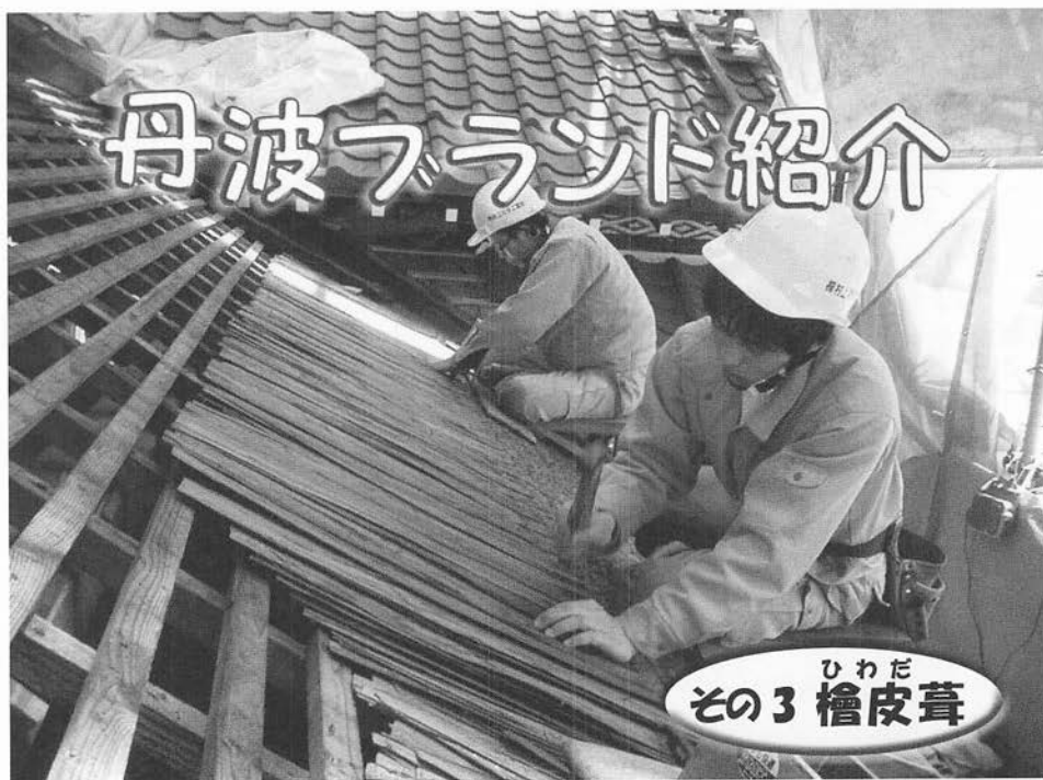
柏原藩陣屋の屋根を葺く村上社寺工芸の葺師（同社提供）
