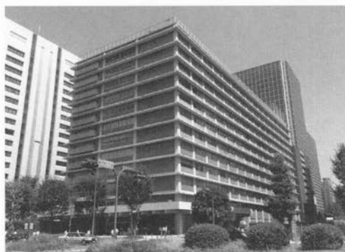
日本郵政株式会社本社ビル
