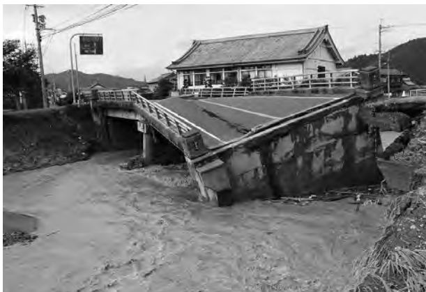
水流で崩壊した前山川と国道175号の合流点にある 八日市橋=市島町上竹田で
